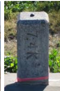
0.2km ごとの距離標 右岸 7.4km
